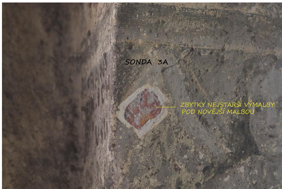
SONDA 3A PROVEDENÁ JINÉ ČÁSTI NA STŘEDNÍ KONZOLE VÝCHODNÍ STĚNY
