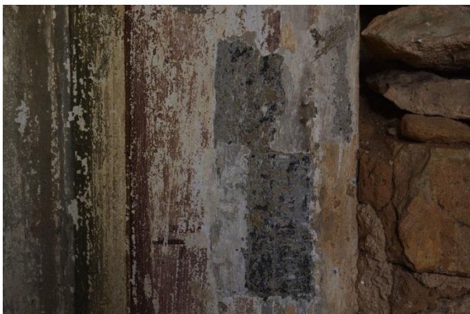
SONDA NA LEVÉ KAMENNÉ STOJCE OSTĚNÍ ZAZDĚNÉHO OTVORU – ZÁPADNÍ STĚNA- POD VRSTVAMI VÝMALEB Z 19. STOLETÍ NEJSTARŠÍ VRSTVA ČERNÉ BARVY NA KAMENI SE ZBYTKY ČERVENÉHO PIGMENTU
