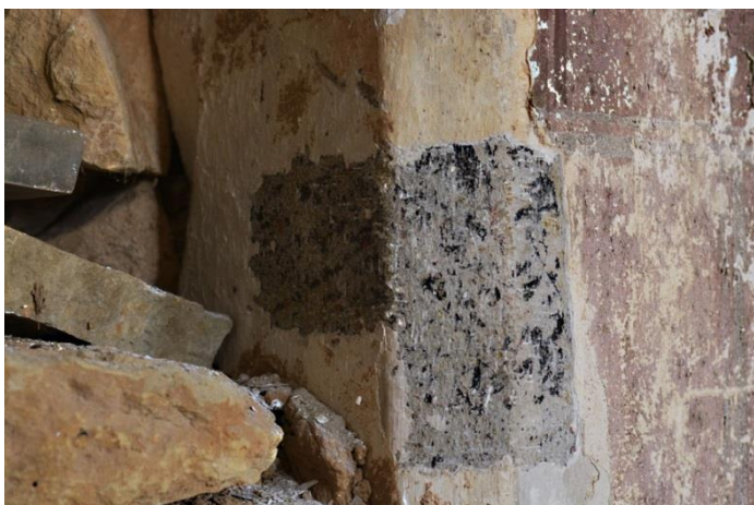
SONDA NA PRAVÉ KAMENNÉ STOJCE OSTĚNÍ ZAZDĚNÉHO OTVORU – ZÁPADNÍ STĚNA - POD VRSTVAMI VÝMALEB Z 19. STOLETÍ NEJSTARŠÍ VRSTVA ČERNÉ BARVY NA KAMENI SE ZBYTKY ČERVENÉHO PIGMENTU
